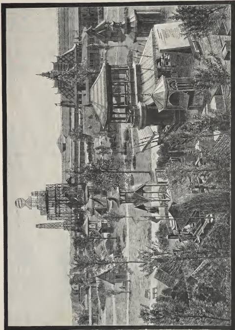
Vue générale du Parc vers le jour de l'ouverture de l'Exposition (3 mai 1885).
